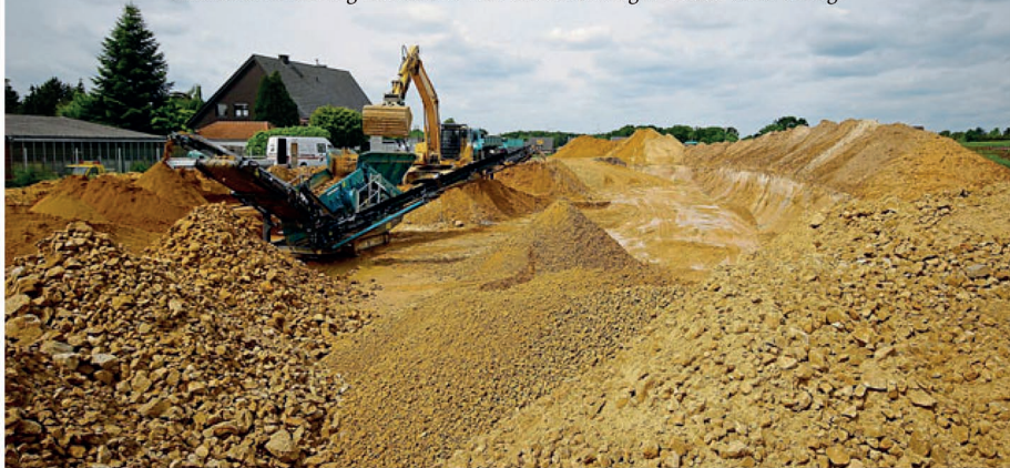
Sand und Steine türmen sich: Für das neue Werkstattgebäude des Autohauses Röttering muss ein Höhenunterschied von mehr als zwei Metern ausgeglichen werden.
